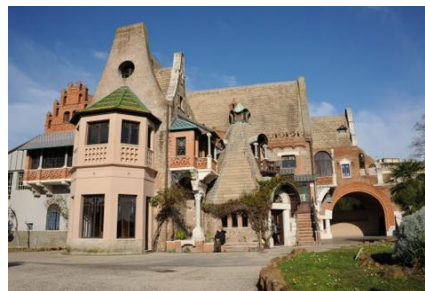
Casina delle civette (villa Torlonia)
